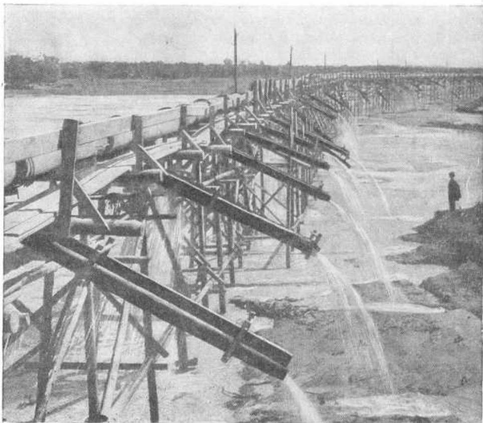
Намыв земляной перемычки на стройке Сталинградской ГЭС.
